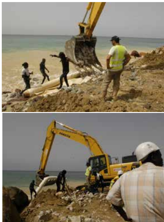
Photo 7 et 8: chantier de digue en construction de Thiawlène
