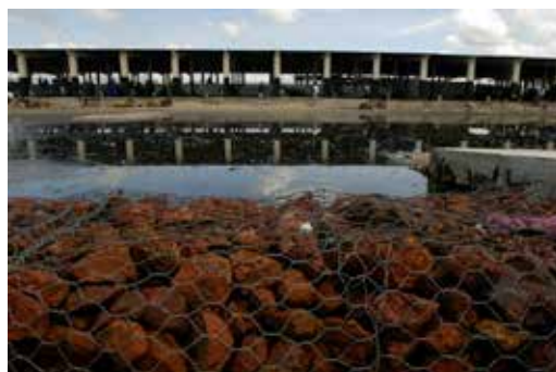
Photo 4: Gabion du quai de pêche de Joal
